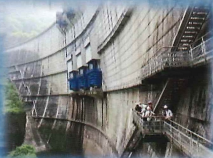
〈ダム管理通路〉
