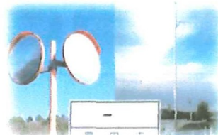
カーブミラー・照明灯 [例]角度調整、不点灯 ※豊田市管理ステッカーが貼ってあるもの
